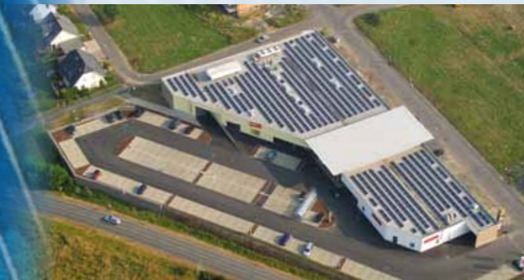
Photovoltaikanlage Lohfelden 134 kWp PV-Anlage
