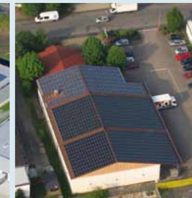
Photovoltaikanlage Kaufungen 102 kWp PV-Anlage
