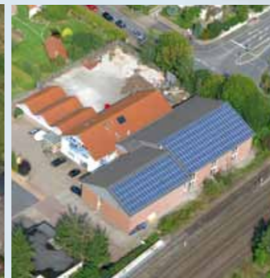
Photovoltaikanlage Brakel 65 kWp PV-Anlage
