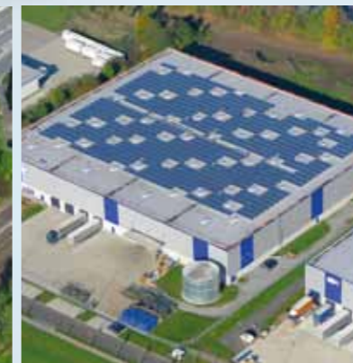
Photovoltaikanlage Gudensberg 416 kWp PV-Anlage
