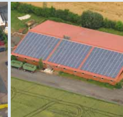
Photovoltaikanlage Gudensberg 91 kWp PV-Anlage
